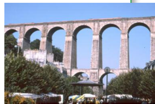
Viaduc de Morlaix
