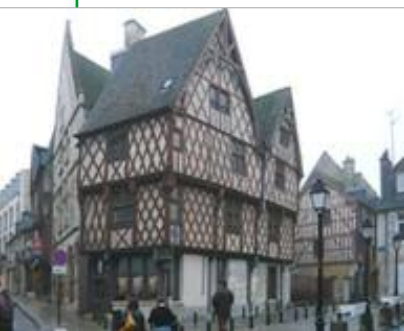
Maisons à pans de bois à Bourges
