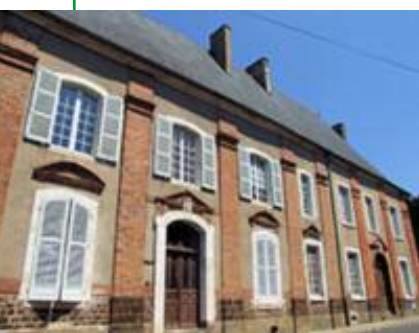
Maison à Henrichement (Origine : Mossot)
