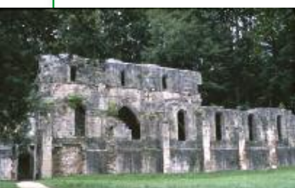
Les Trois-Fontaines Avant Restauration
