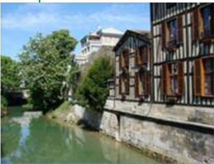
Pan de bois sur le Nau à Châlons-en-Champagne
