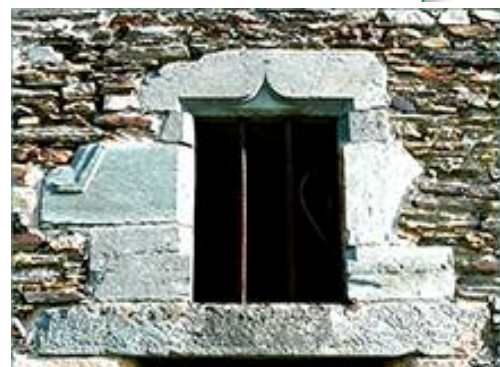
Ré-emploi de pierre bleue dans un encadrement de fenêtre du XVIII e siècle, à Pouancé.
