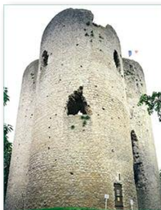
Tour quadrilobée de Guinette à Etampes
