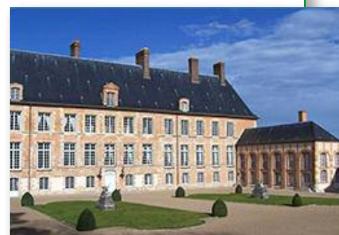
Château des Mesnuls, façade principale
