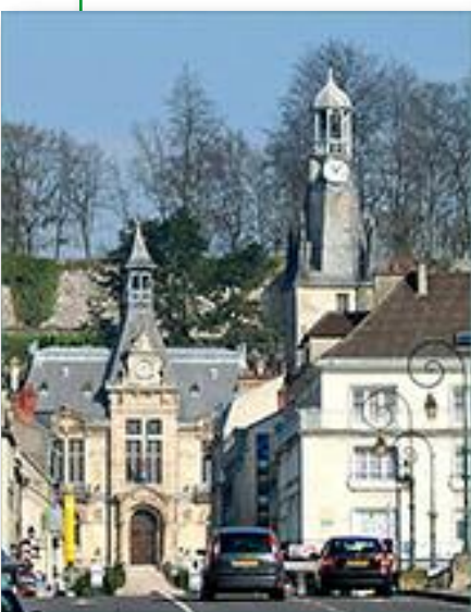
Mairie de Château-Thierry et les remparts
