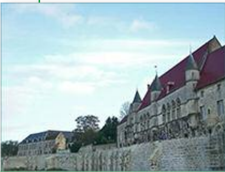
La porte d'Ardon et les remparts Sud de Laon illustration : Rémi
